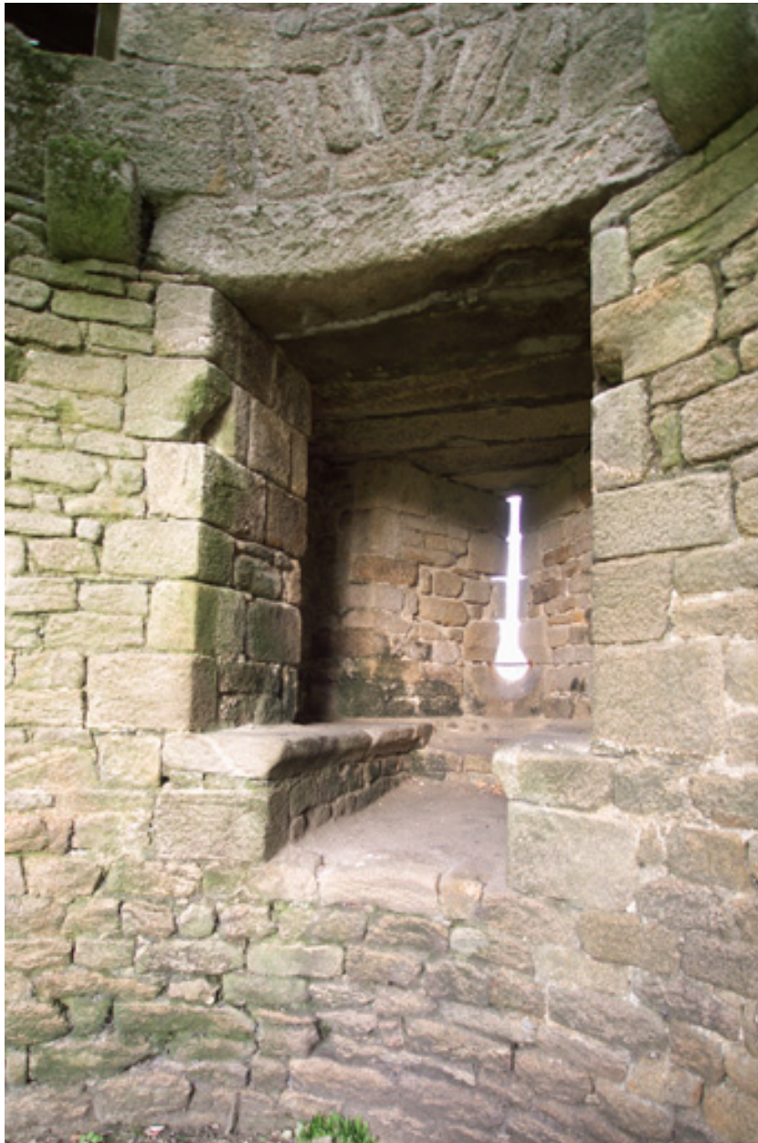
Ouverture de tir au premier étage.
