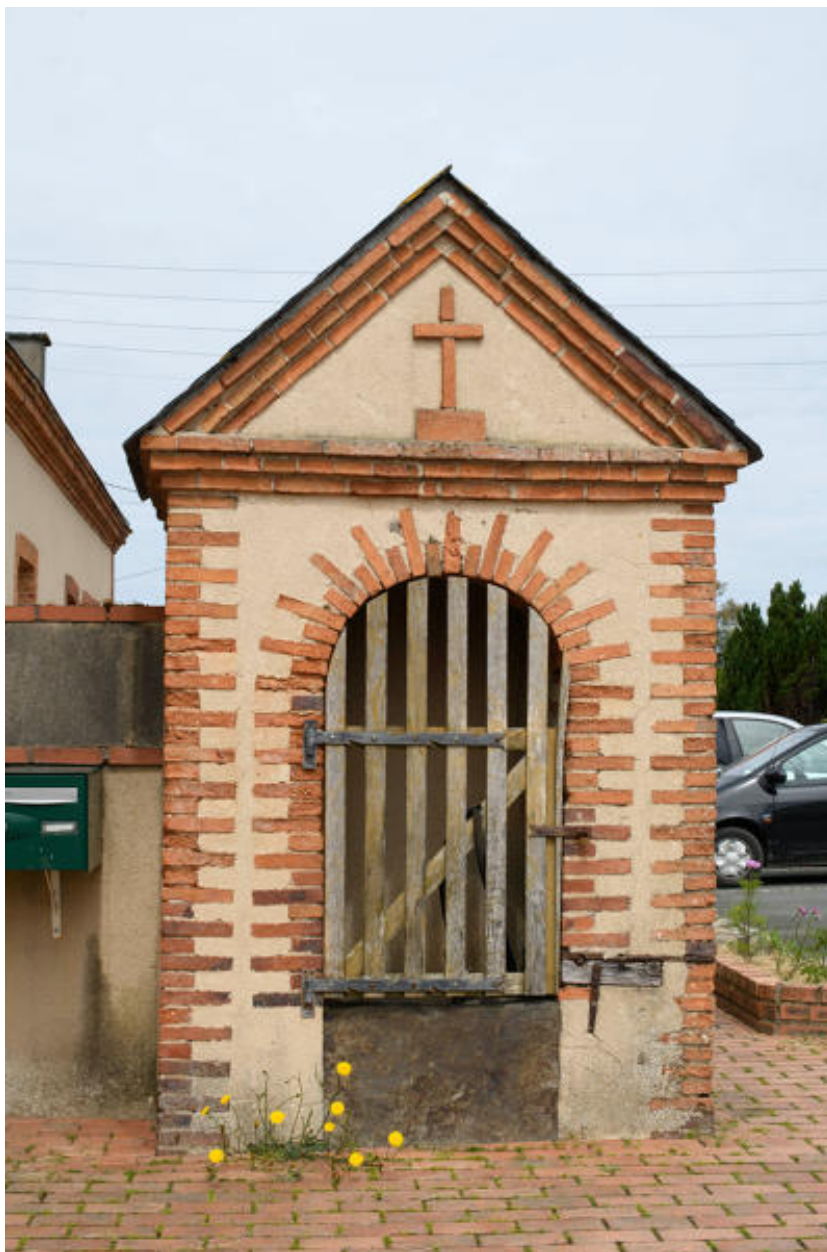
Puits à double accès de l'école publique.
