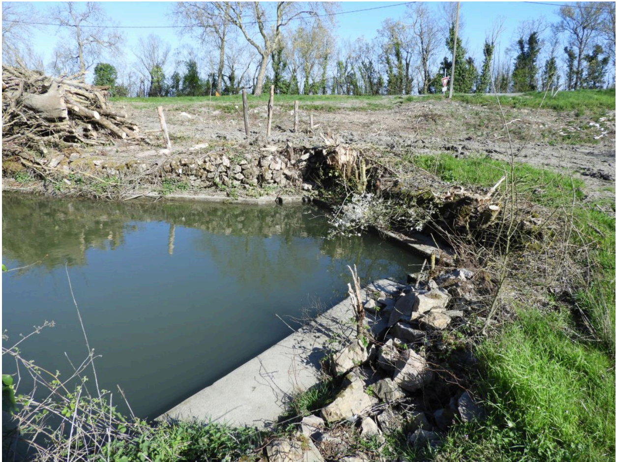
Le débouché du second aqueduc dans le Contrebot de Vix, vu depuis le sud.
