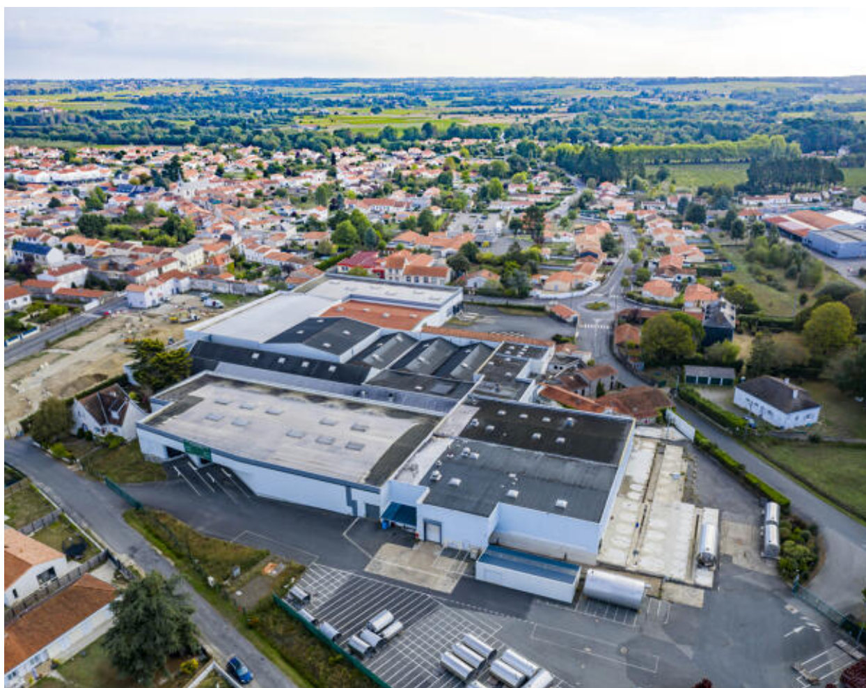
Vue des bâtiments de production depuis l'ouest.
