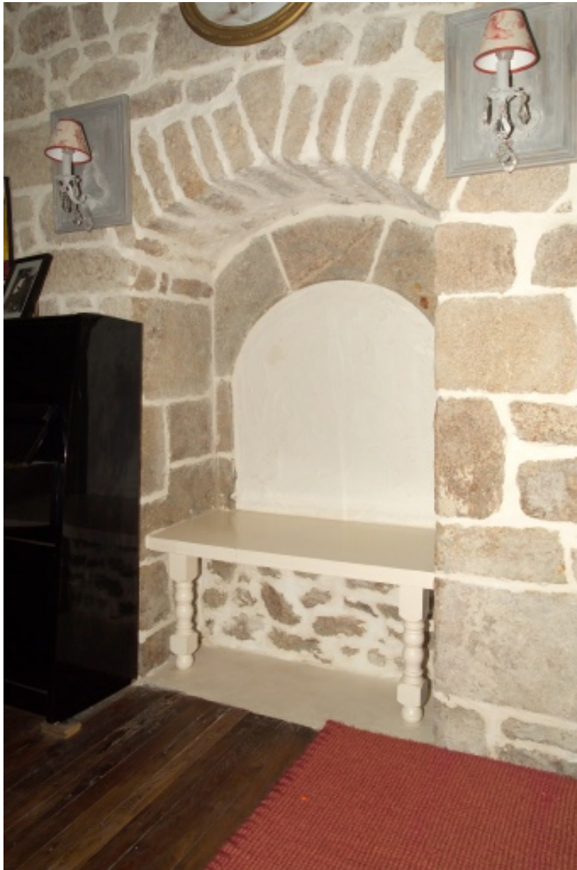
Porte murée à l'intérieur du bâtiment (partie sud).
