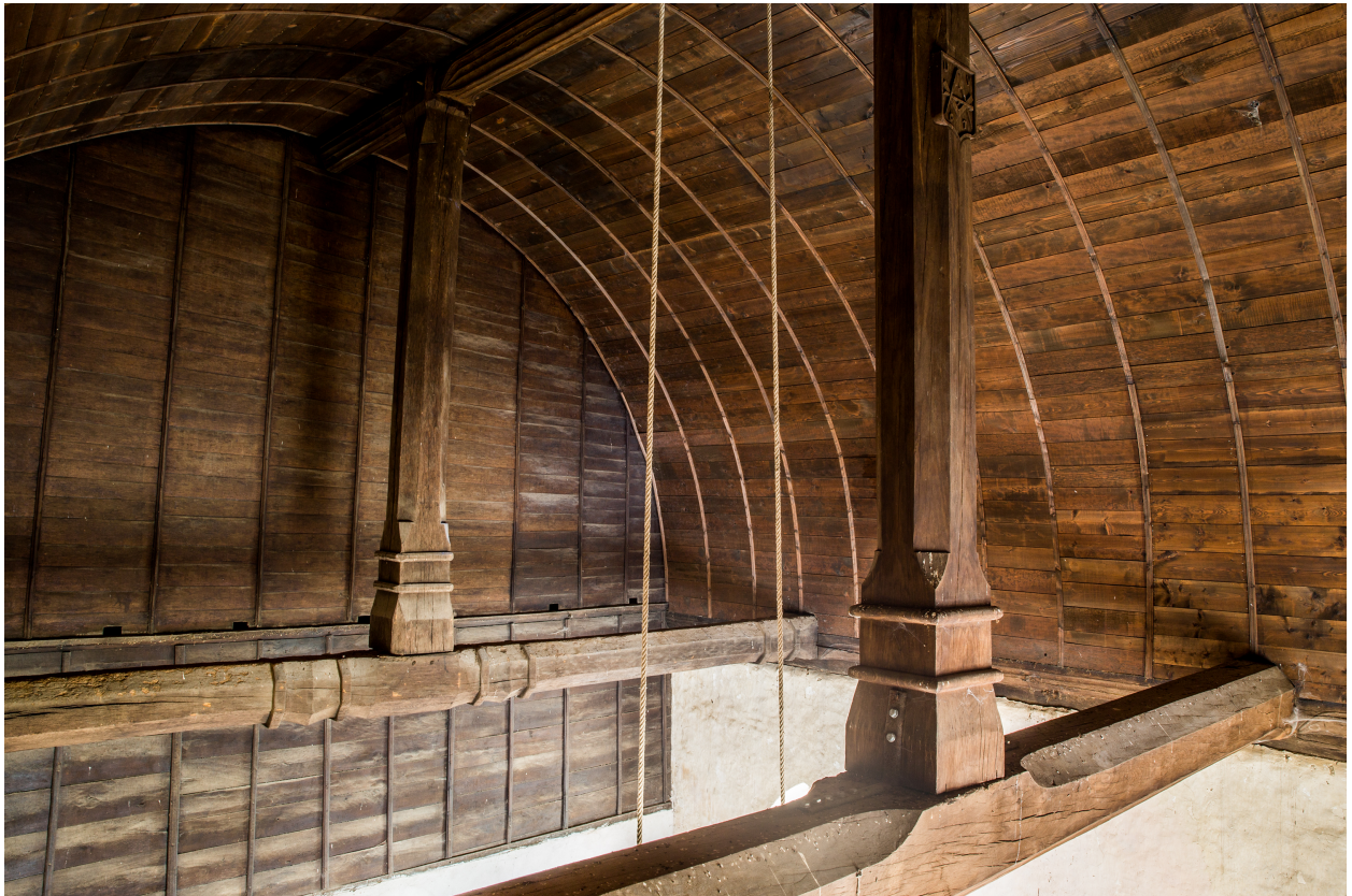
La charpente et le lambris de la nef.
