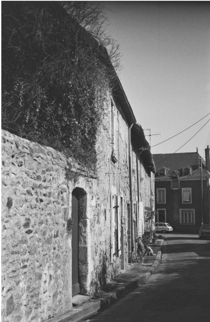
Vue des façades ouest, côté rue.
