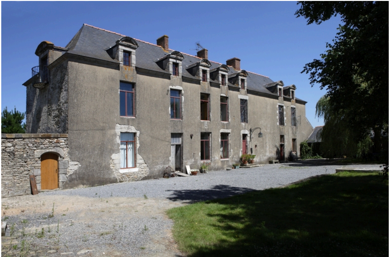
Logis. Vue de la façade sud depuis l'ouest.
