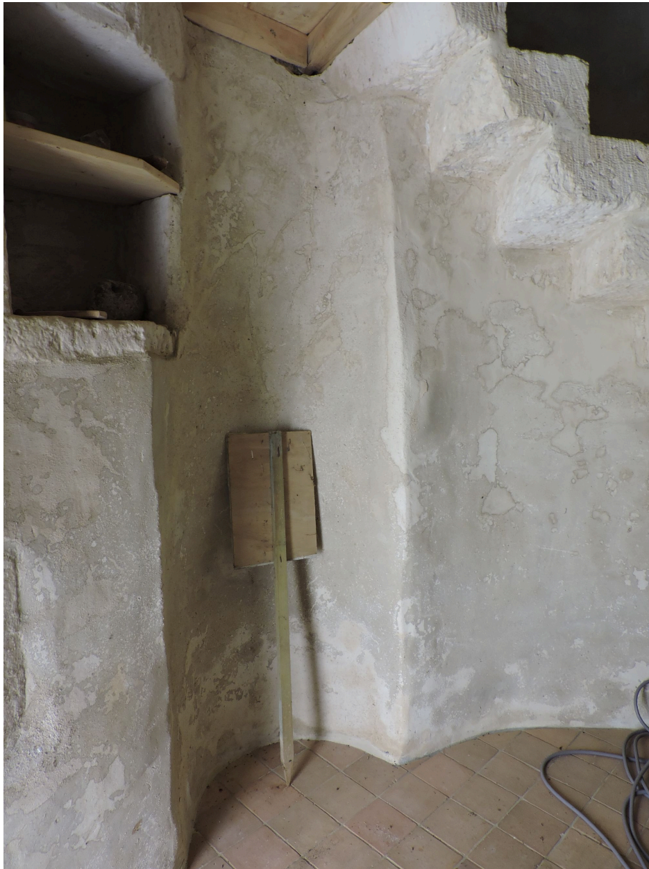
Vue intérieure du moulin.
