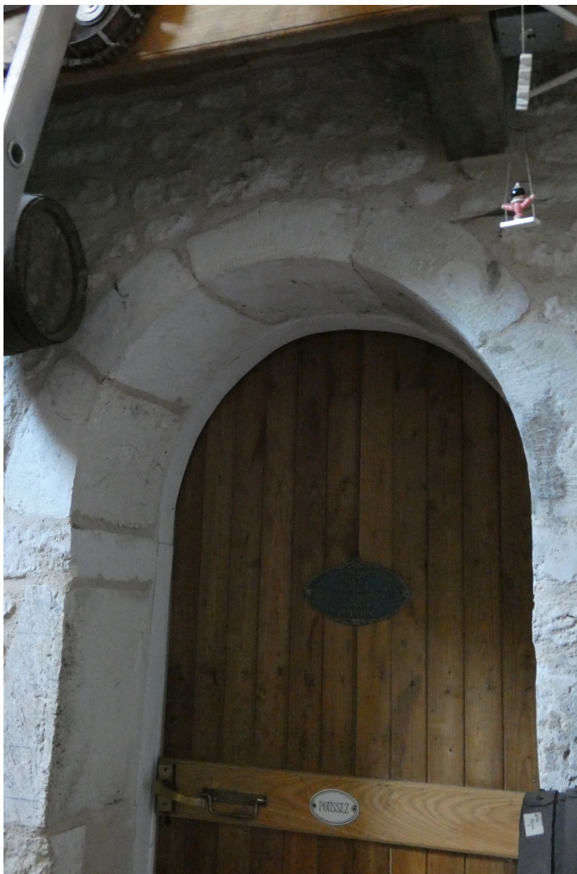
Porte en arc en plein cintre à l'intérieur de la dépendance.
