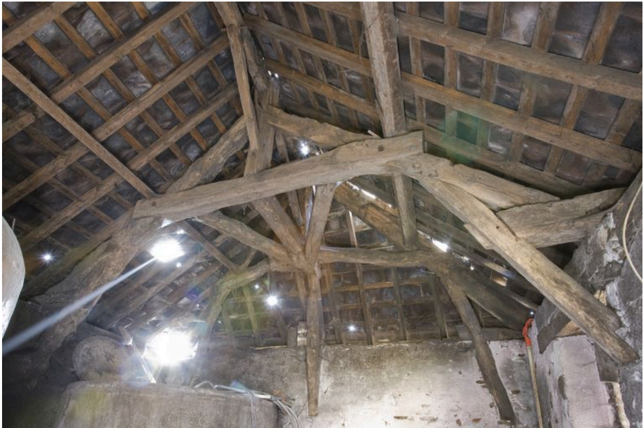
Cellier : détail de charpente.
