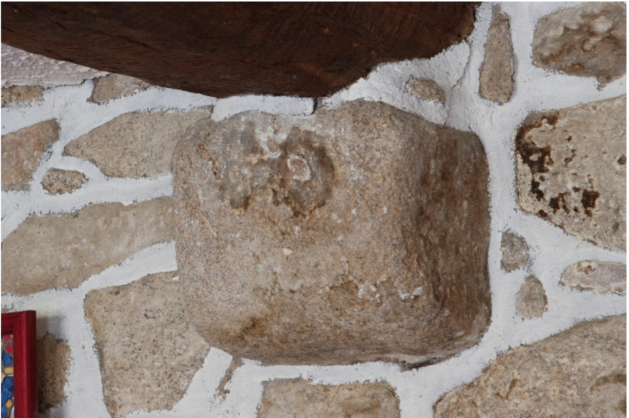
Détail d'un corbeau supportant une poutre de plancher du 1er étage du logis est.
