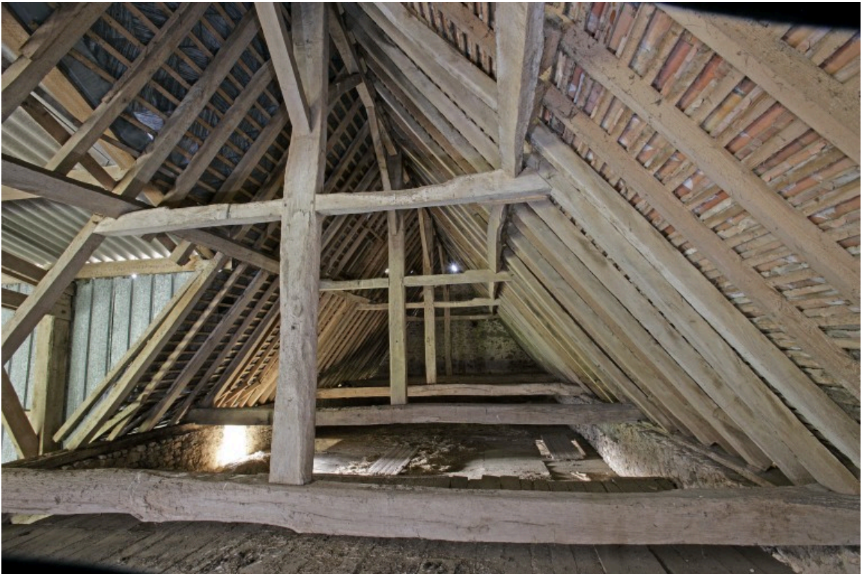
La charpente du second logis-étable vue depuis le sud-est.
