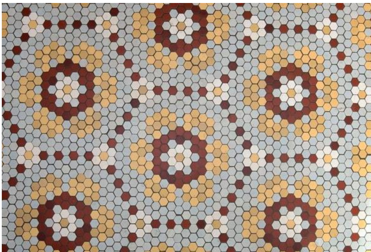
Détail du carrelage.
