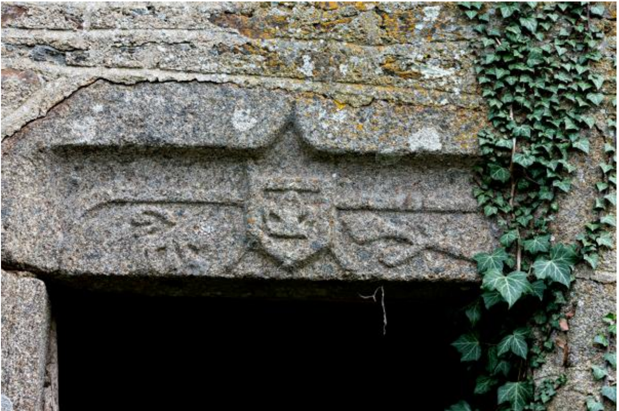
Linteau de porte armorié en accolade, façade ouest, alignement est
