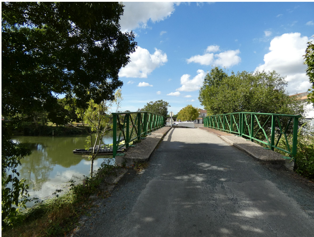
Le pont vu depuis l'est.
