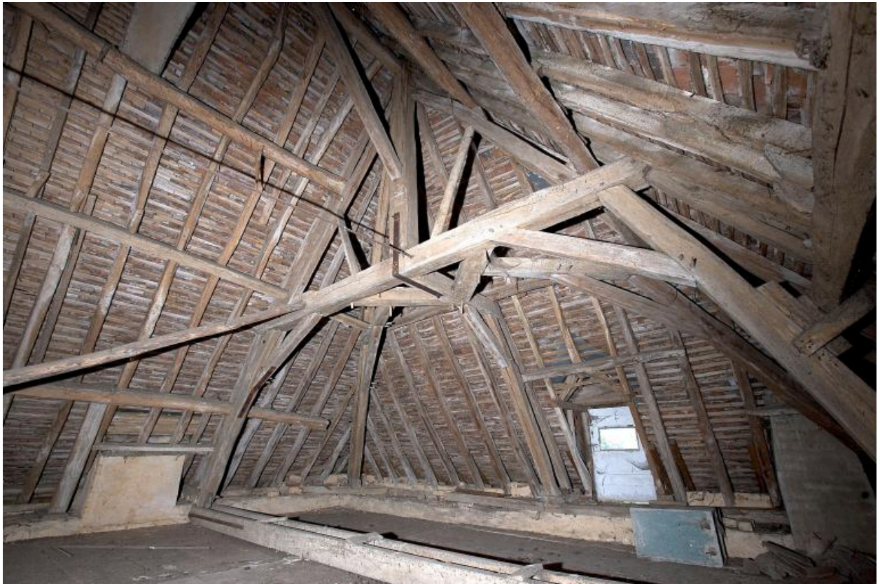
Le pavillon, comble, détail de la charpente, 2007.
