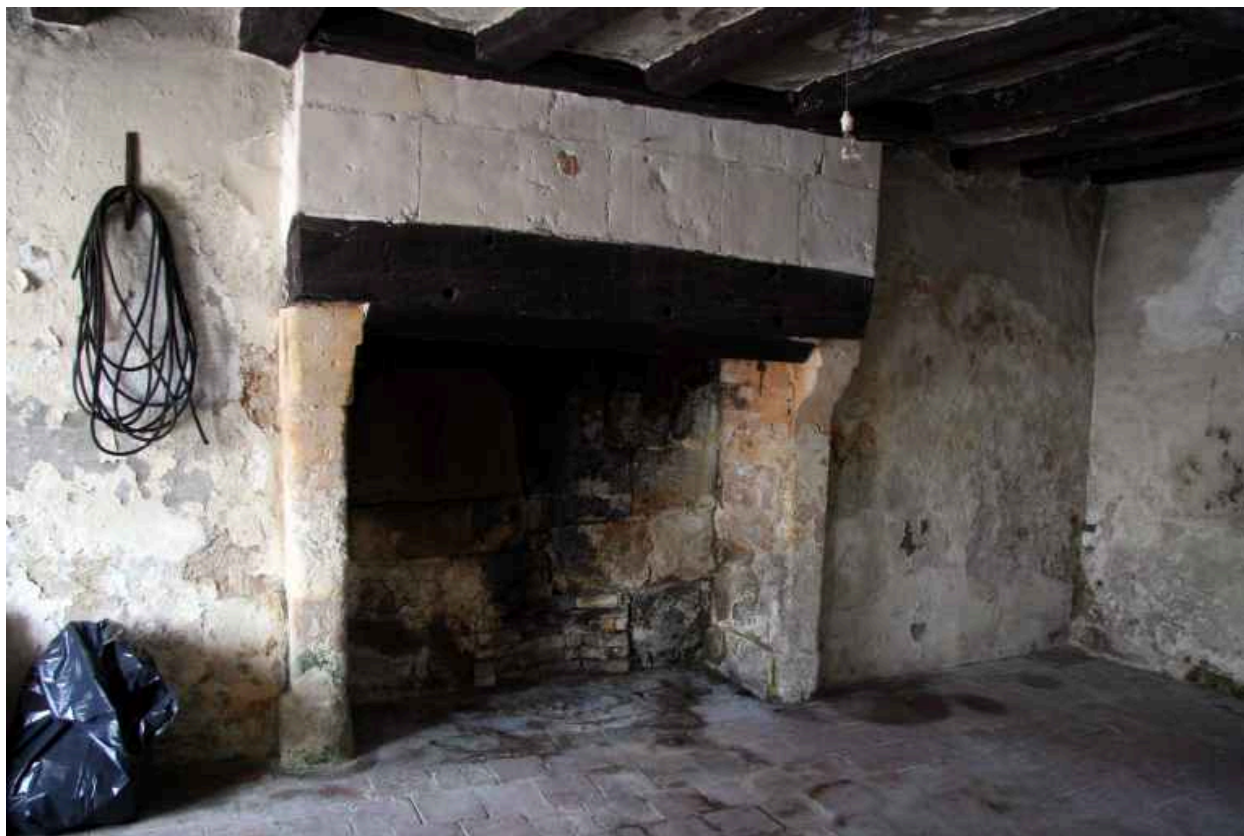
Cheminée avec linteau de bois.
