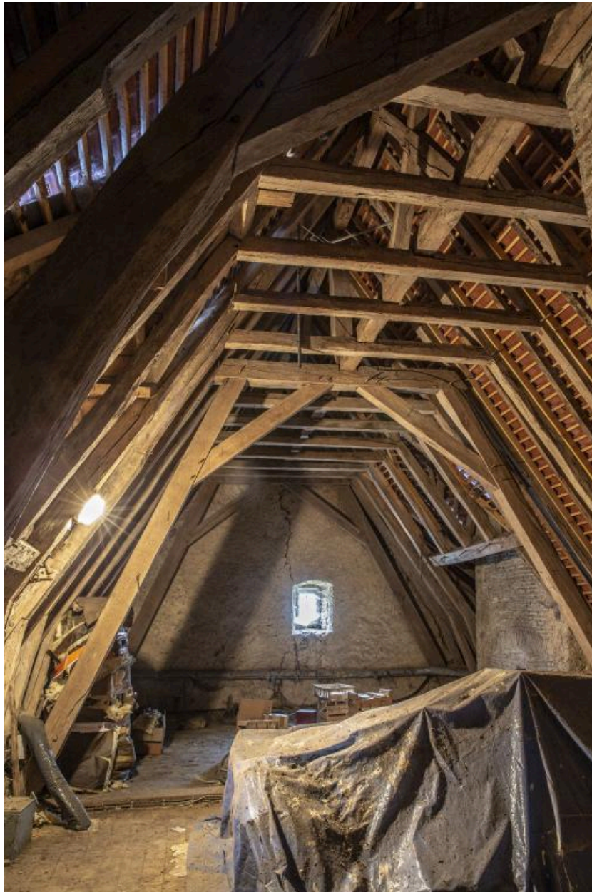
La charpente de la partie haute du logis.
