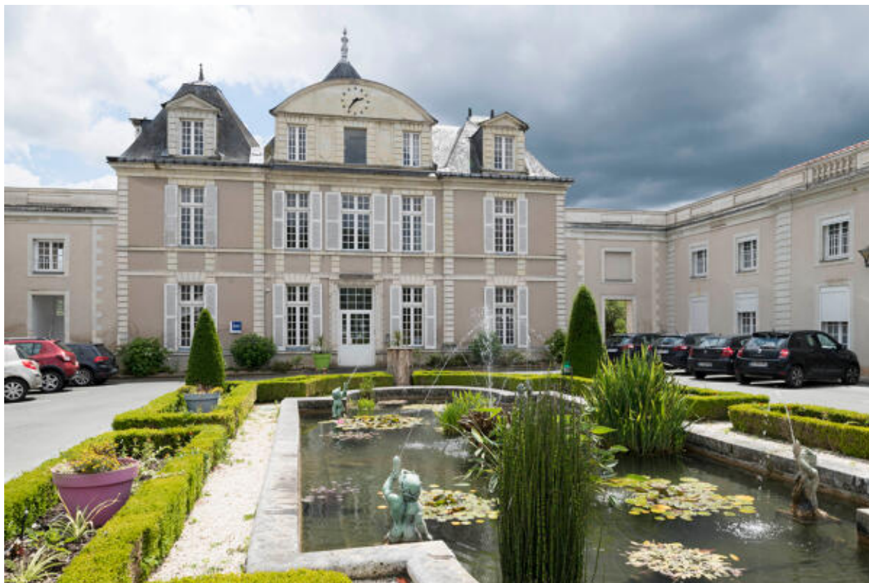
Vue de la façade nord et de la cour du château.
