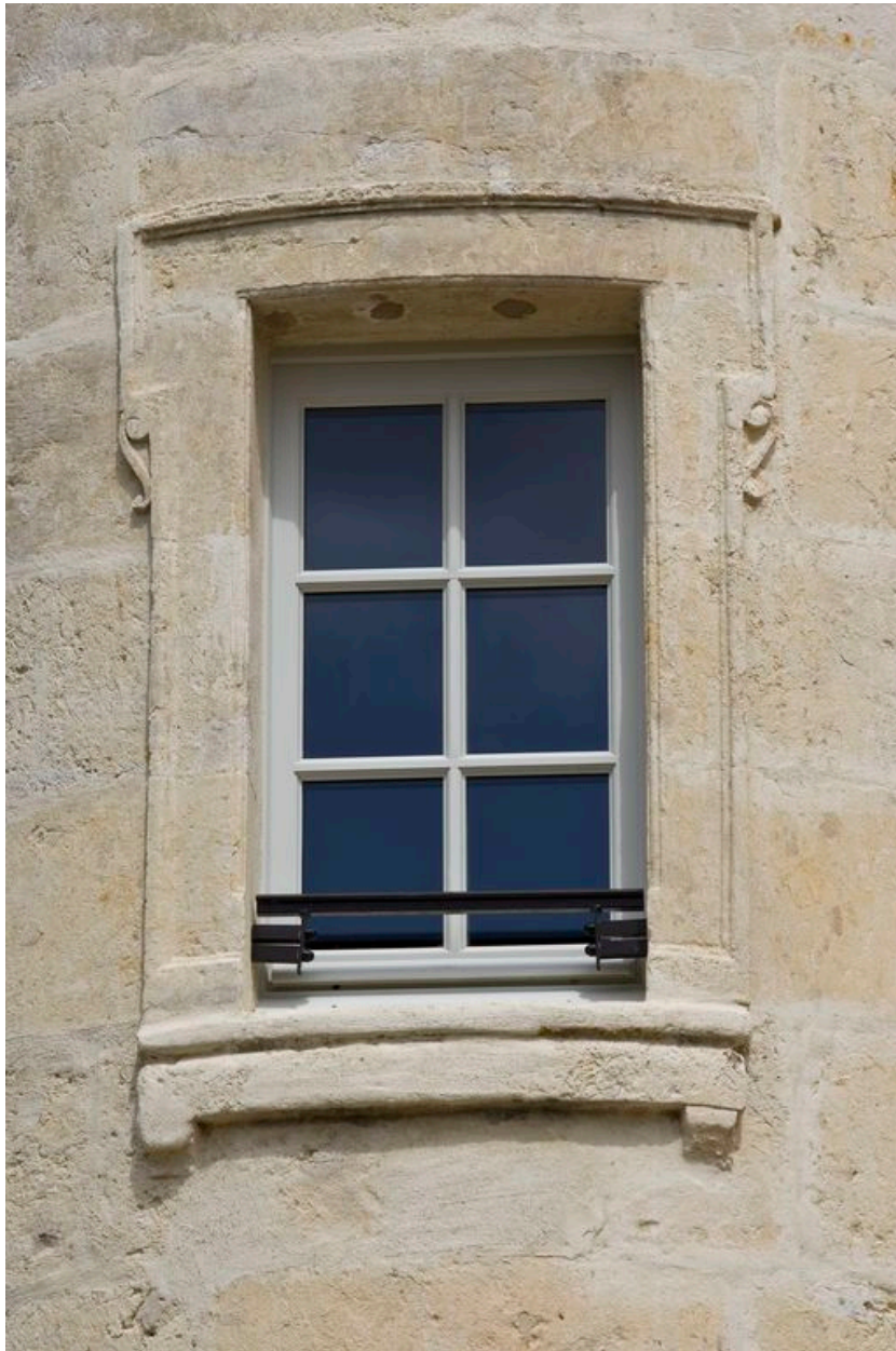
Fenêtre de la tourelle sud du logis
