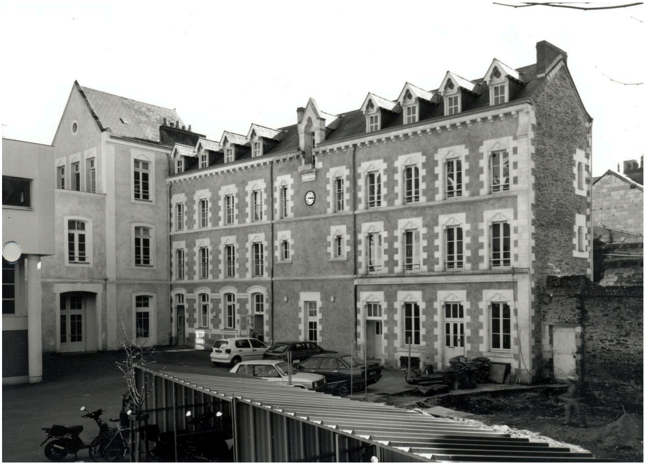
Externat Saint-Maurille, bâtiment scolaire sud : élévation antérieure.
