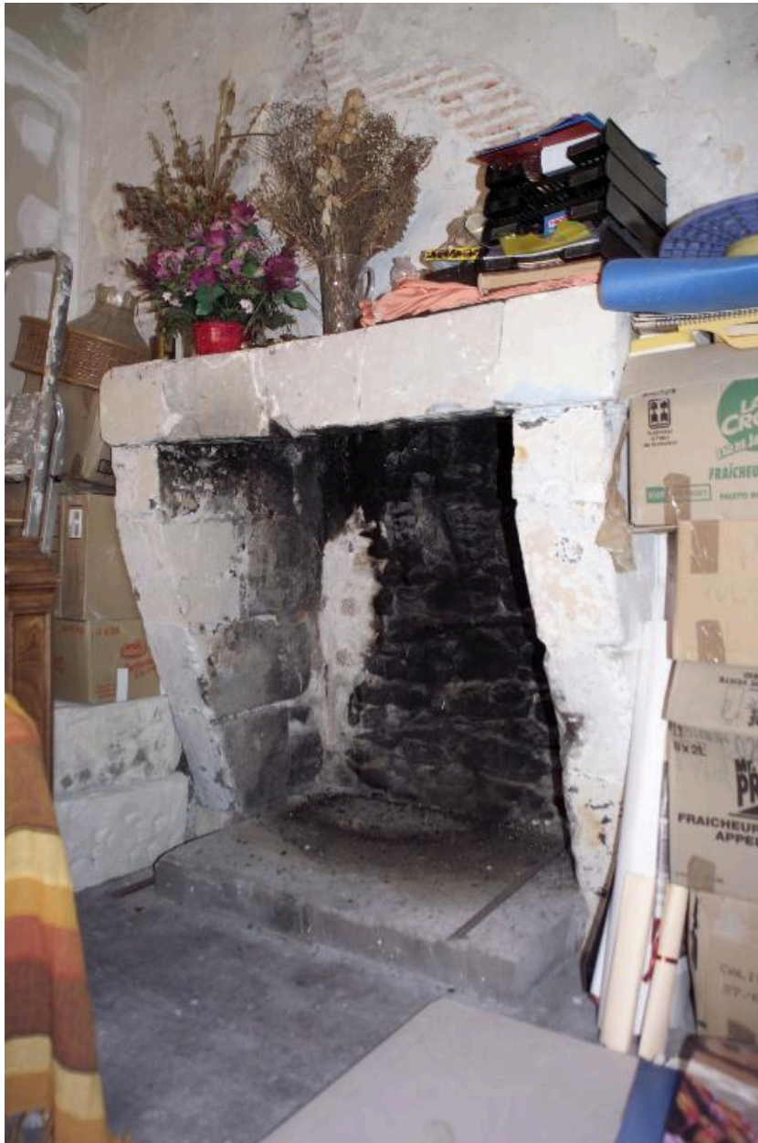
Le corps secondaire, premier étage, la cheminée.
