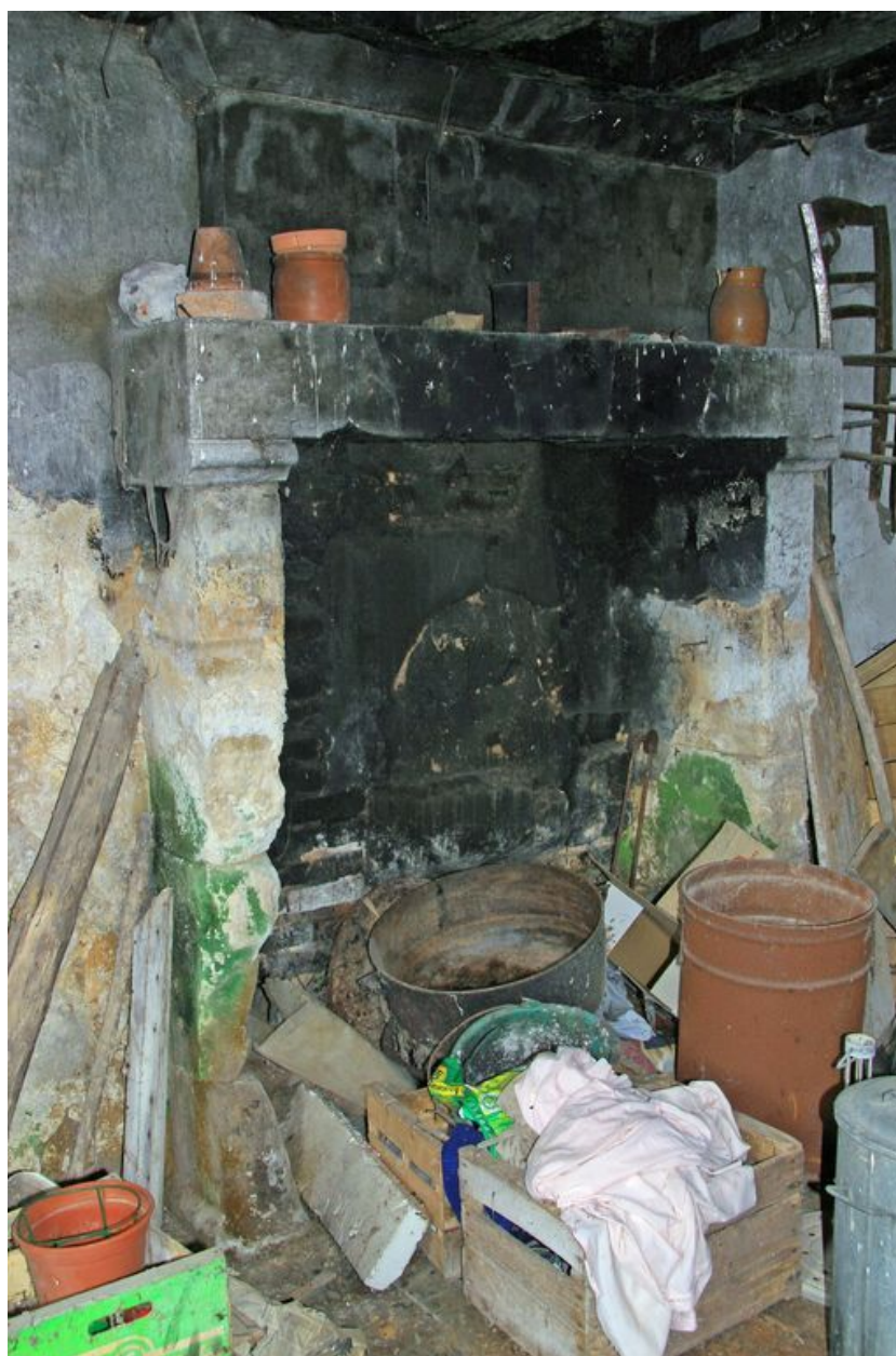
Le moulin, maison d'habitation : cheminée.
