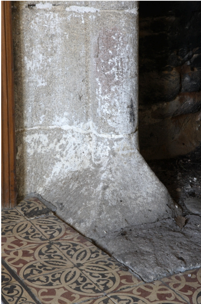
Aile ouest. Salle haute. Base du piédroit de gauche de la cheminée.
