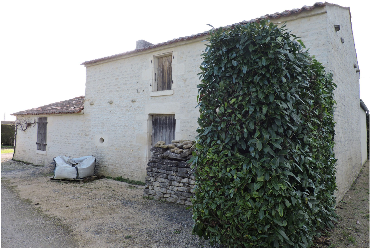
L'ancien logement, à l'est, vu depuis le nord-est.
