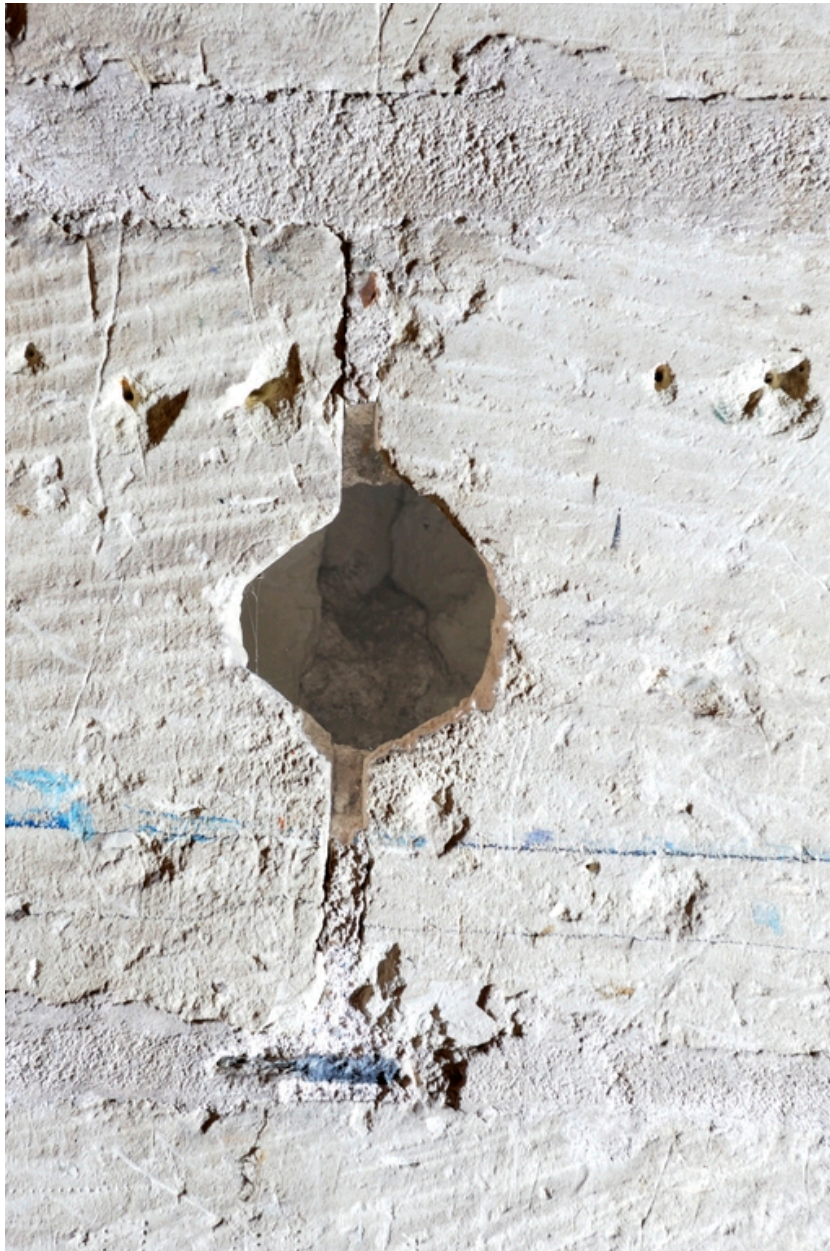
Ancienne chapelle nord (fin XVe siècle), comble, mur sud. Détail d'un trou de boulin.
