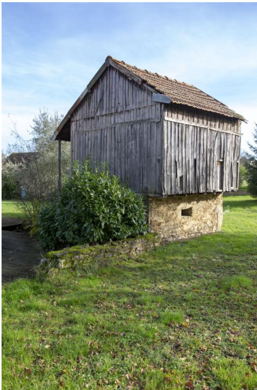
Vue de l'annexe agricole depuis l'ouest.
