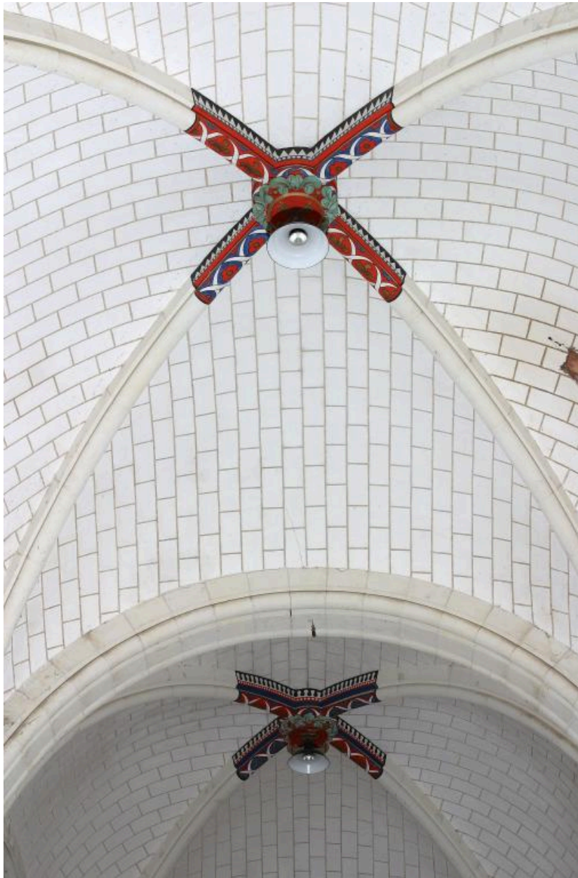
Chœur, voûte : décor d'accompagnement des clés de voûte.
