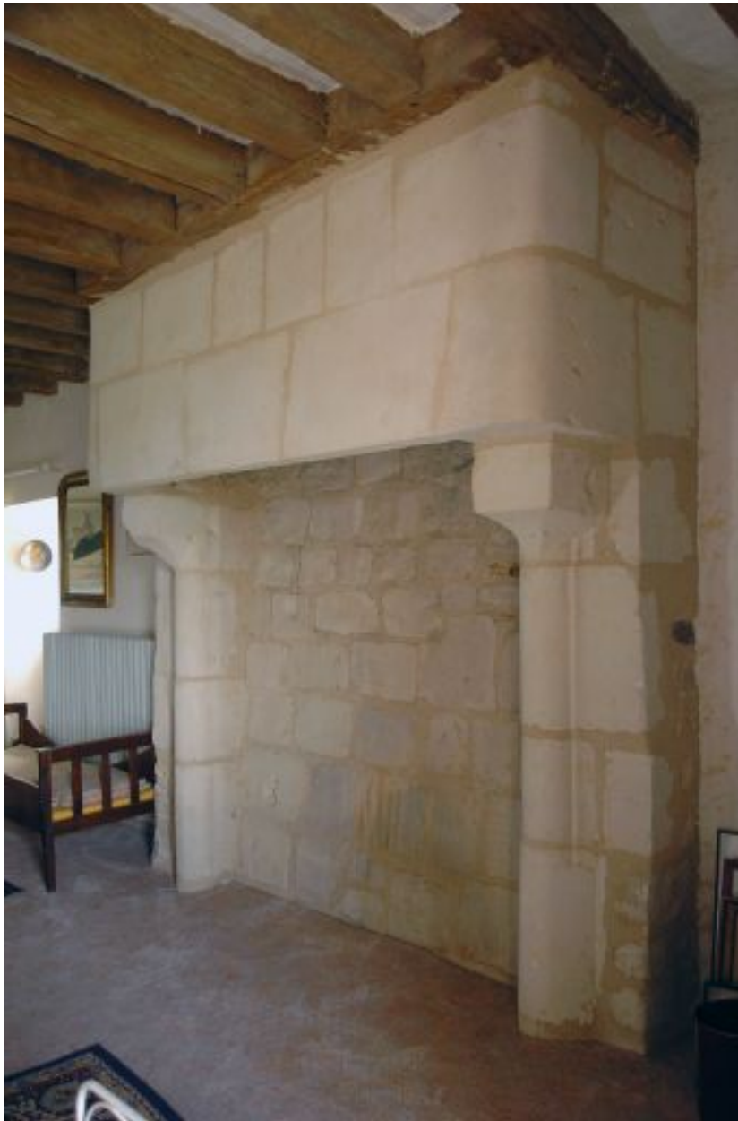
1er étage, pignon est : cheminée.
