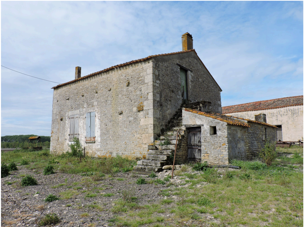
Le logis vu depuis l'est.
