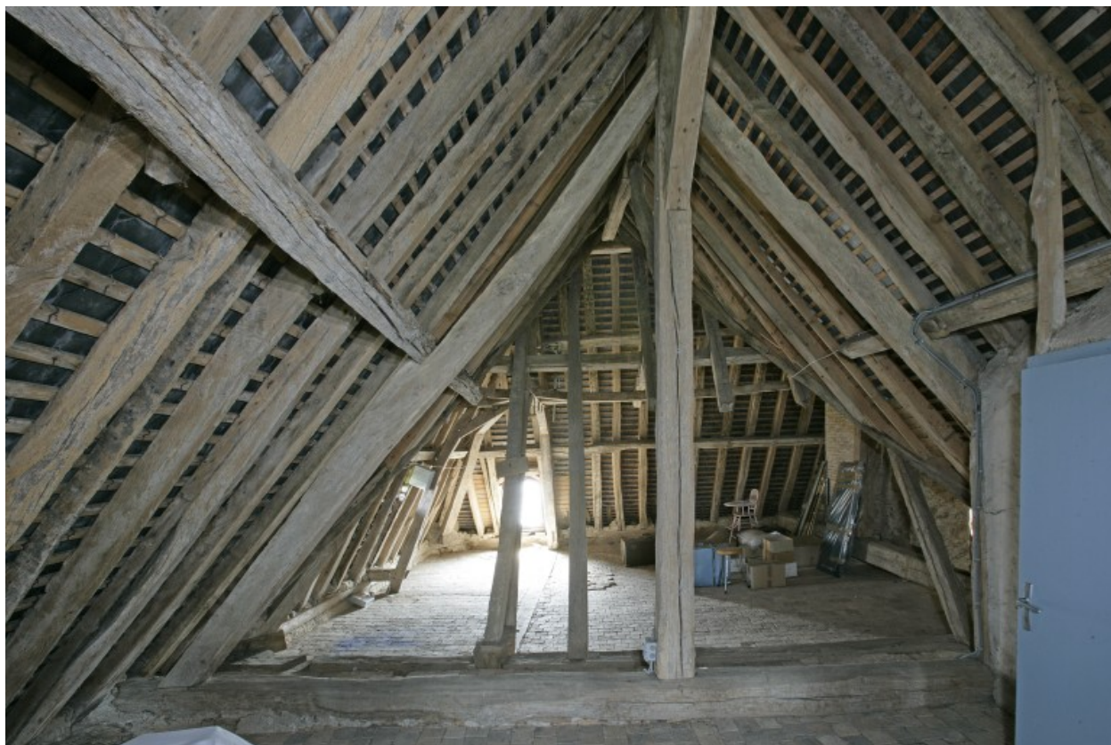
La charpente du corps secondaire vue depuis le nord.
