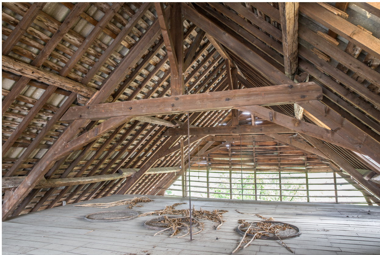
Le comble du séchoir.
