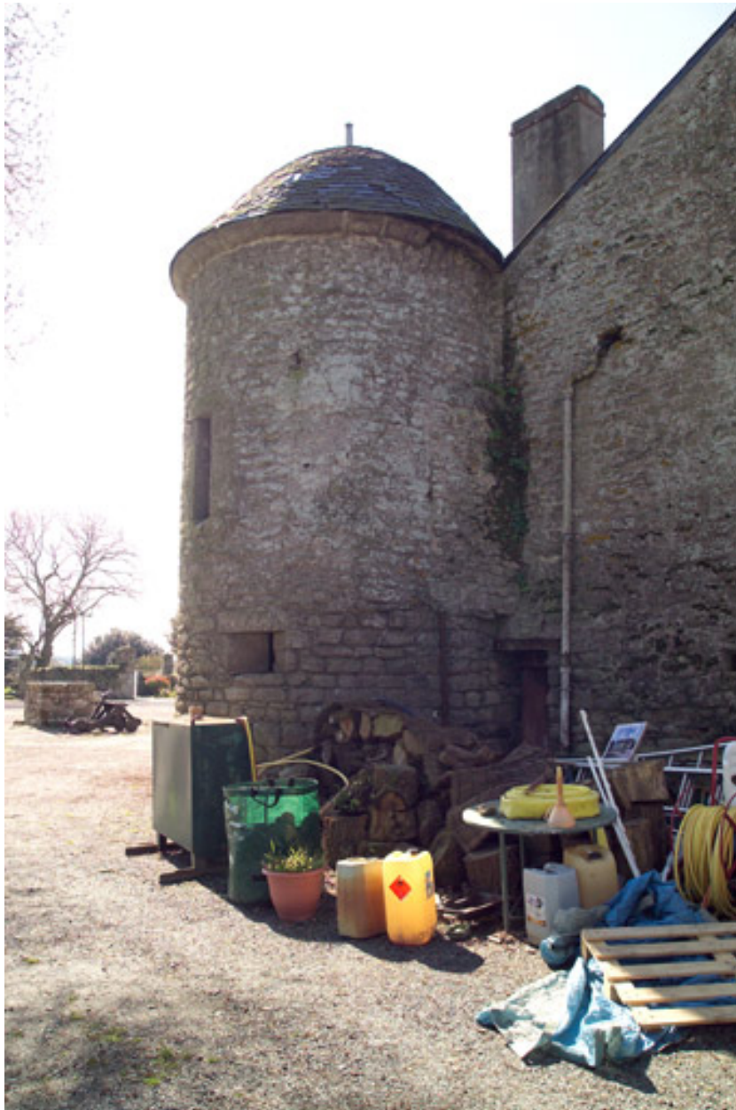
Tourelle sur l'angle du logis, ensemble depuis l'est.
