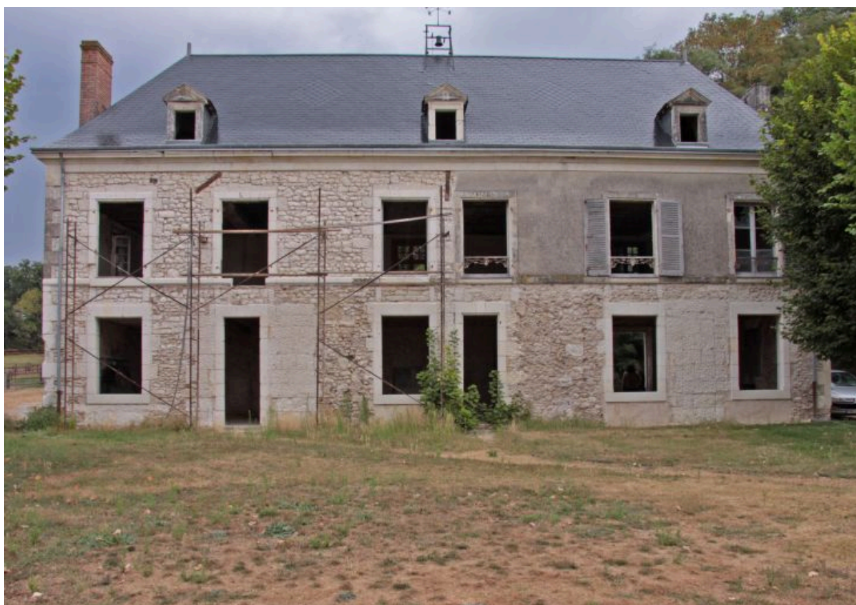
La maison : façade antérieure.
