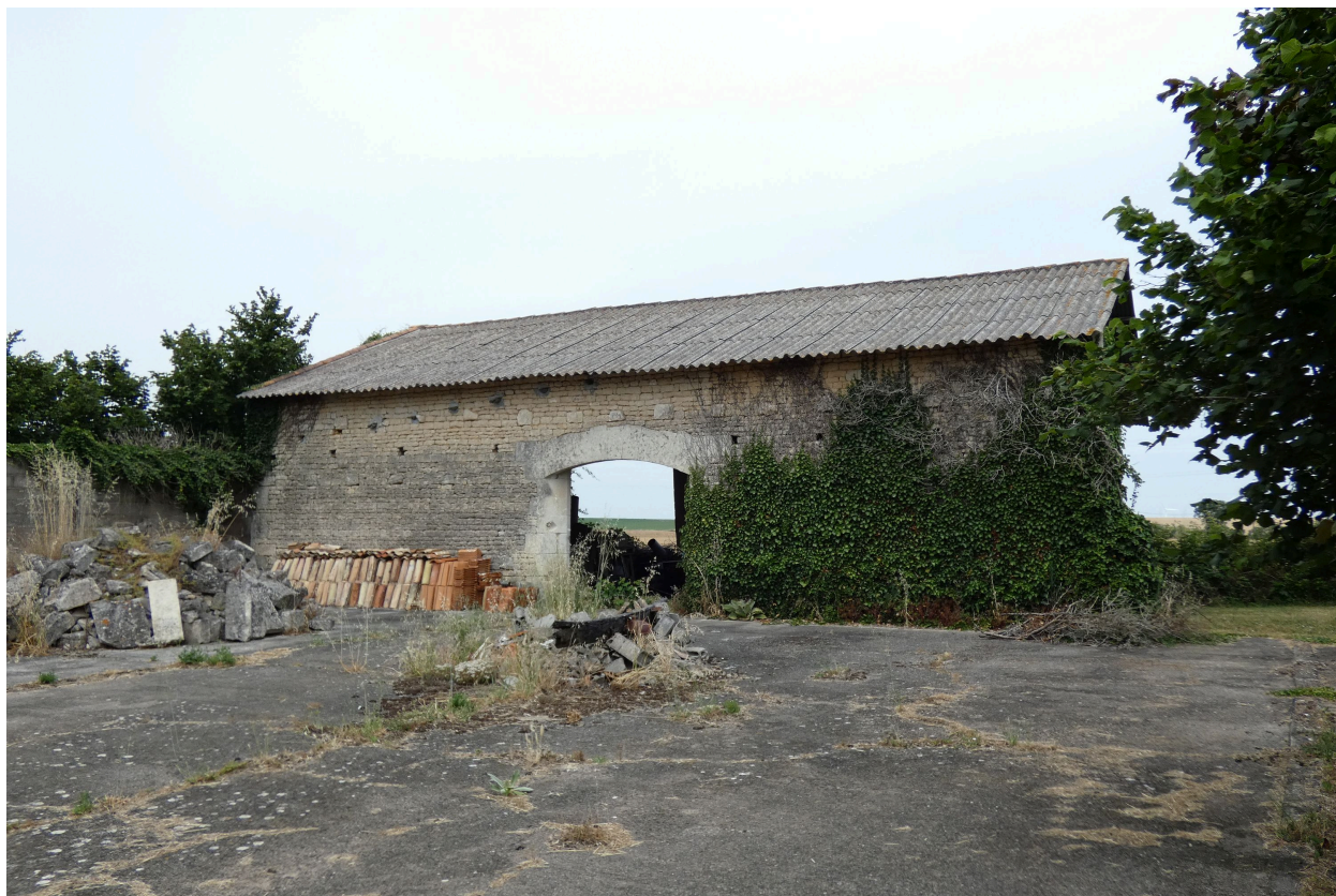
La grange au nord de l'ensemble, vue depuis le sud.
