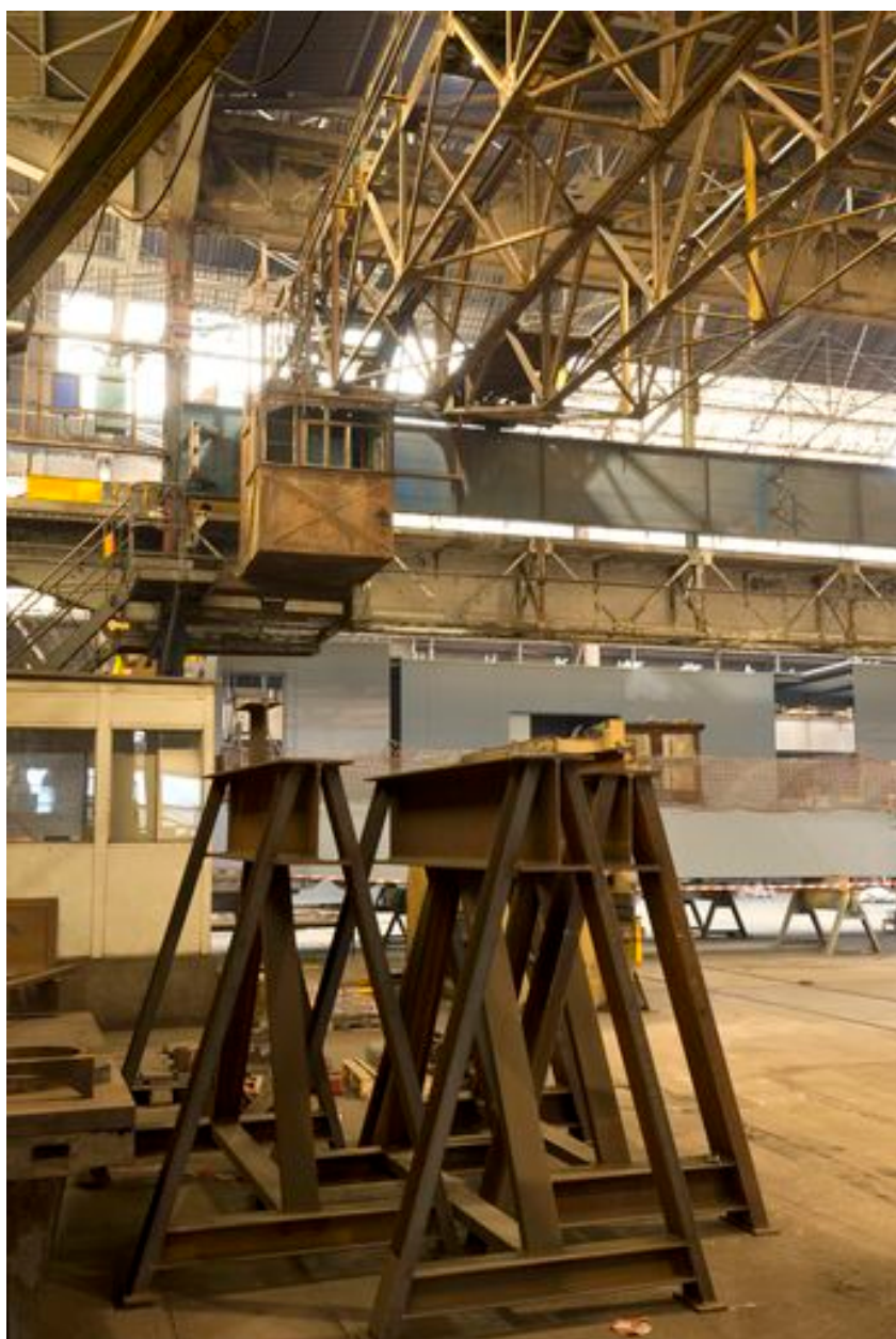
Ancienne pont roulant manoeuvré par des cabines.
