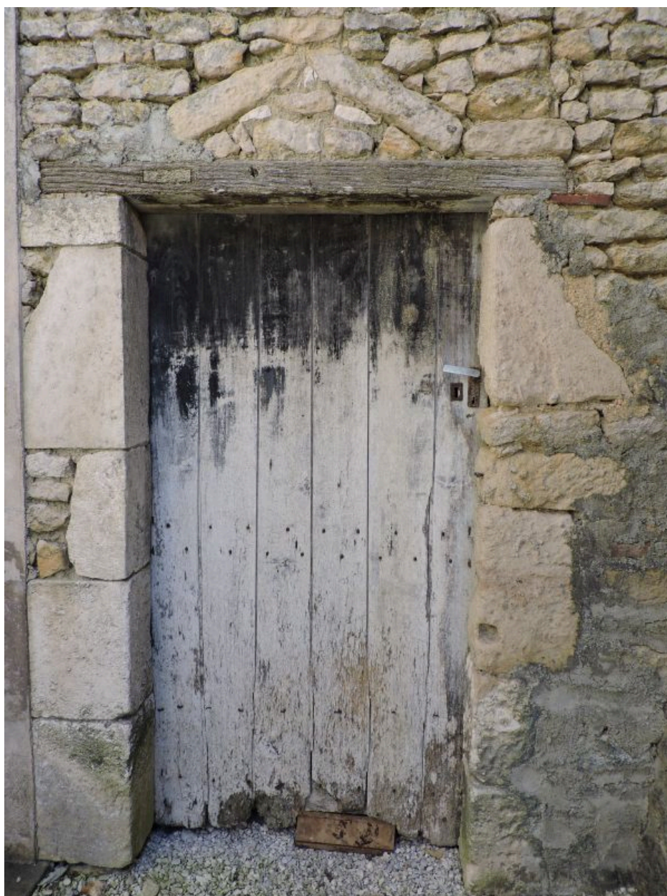
Porte d'une des dépendances au sud de la cour.
