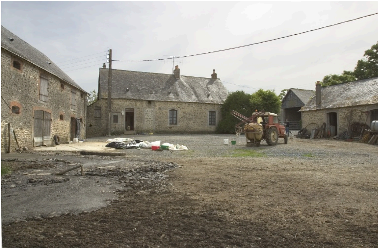
Vue d'ensemble depuis le nord : l'étable, le logis, la remise, le logement-toit à porcs.
