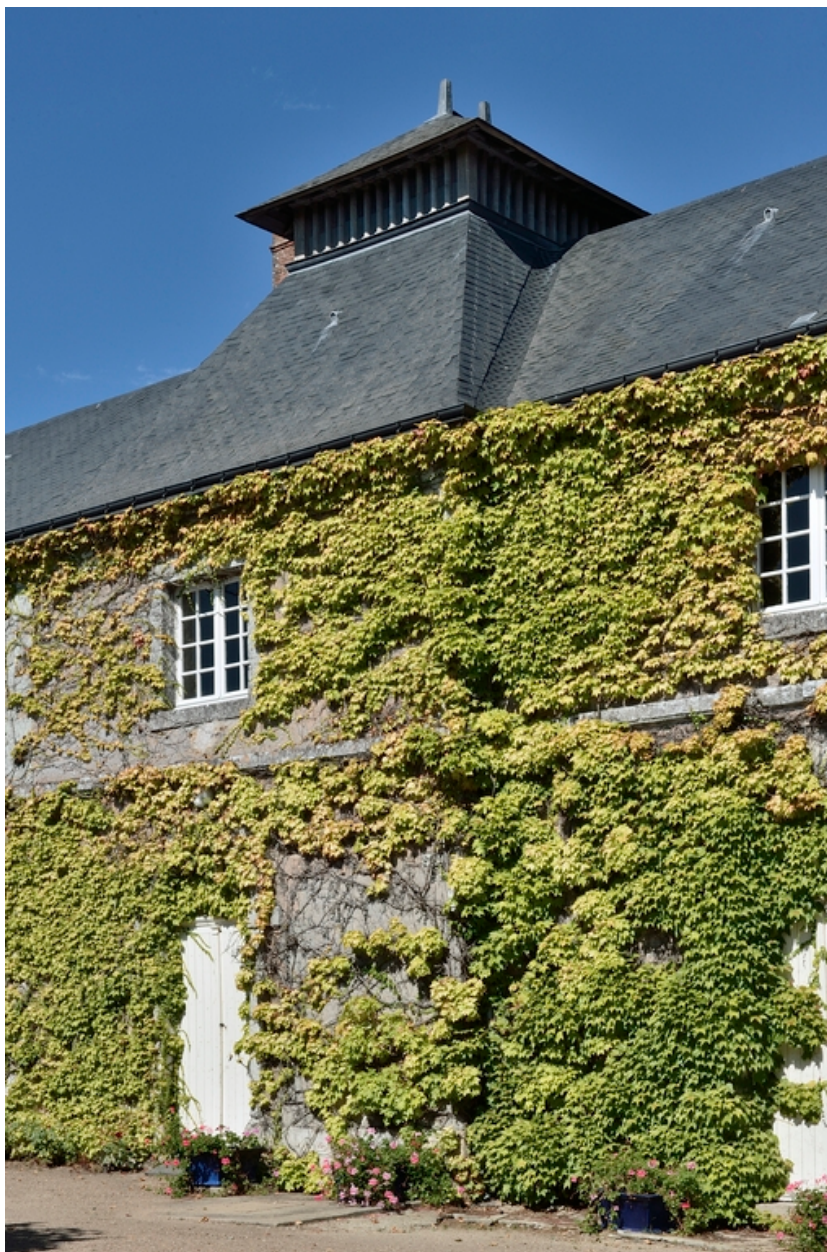
Chai. Façade sud. Détail du belvédère.
