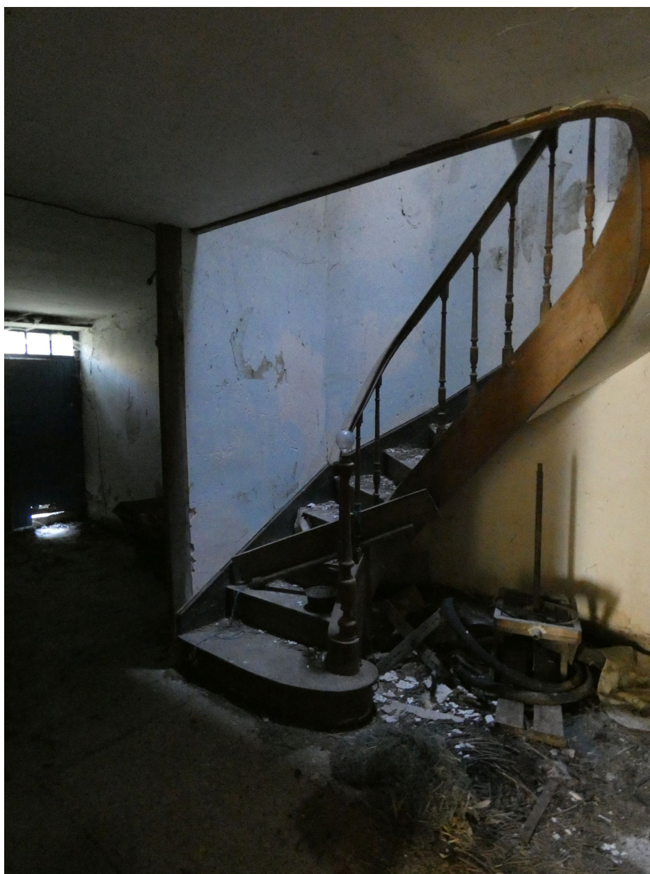
L'escalier en bois dans le logis.
