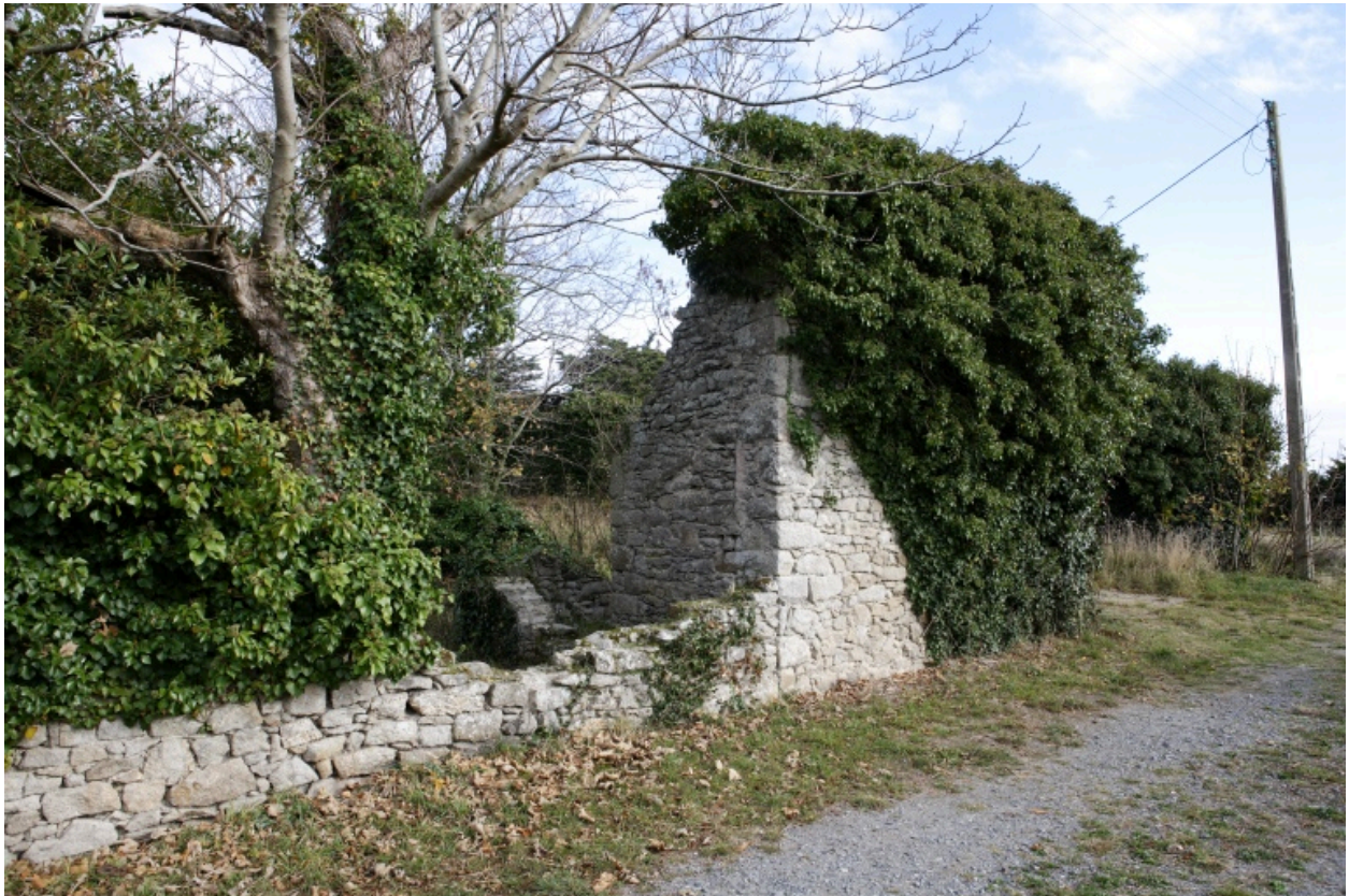
Mur de clôture. Tour d'angle sud-ouest.
