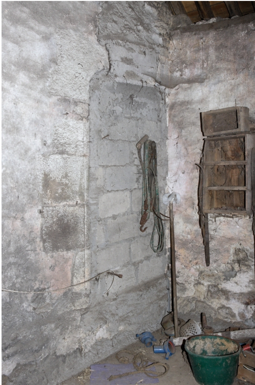
Logis. Partie est. Rez-de-chaussée. Porte bouchée.
