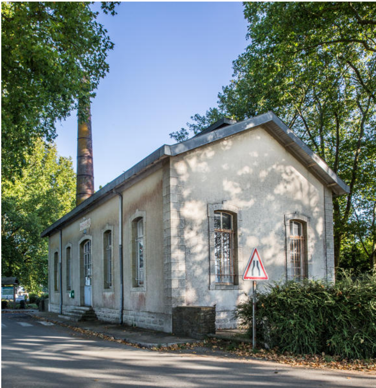
Façade antérieure et pignon sud.
