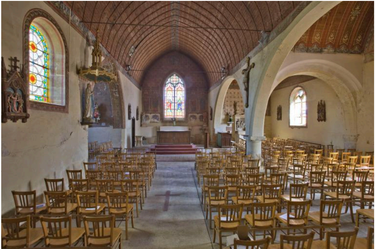
Vue intérieure depuis la nef
