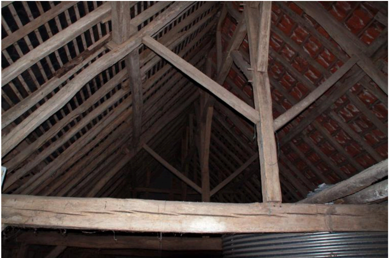
Grange-étable, charpente à pannes avec faux-entrait.
