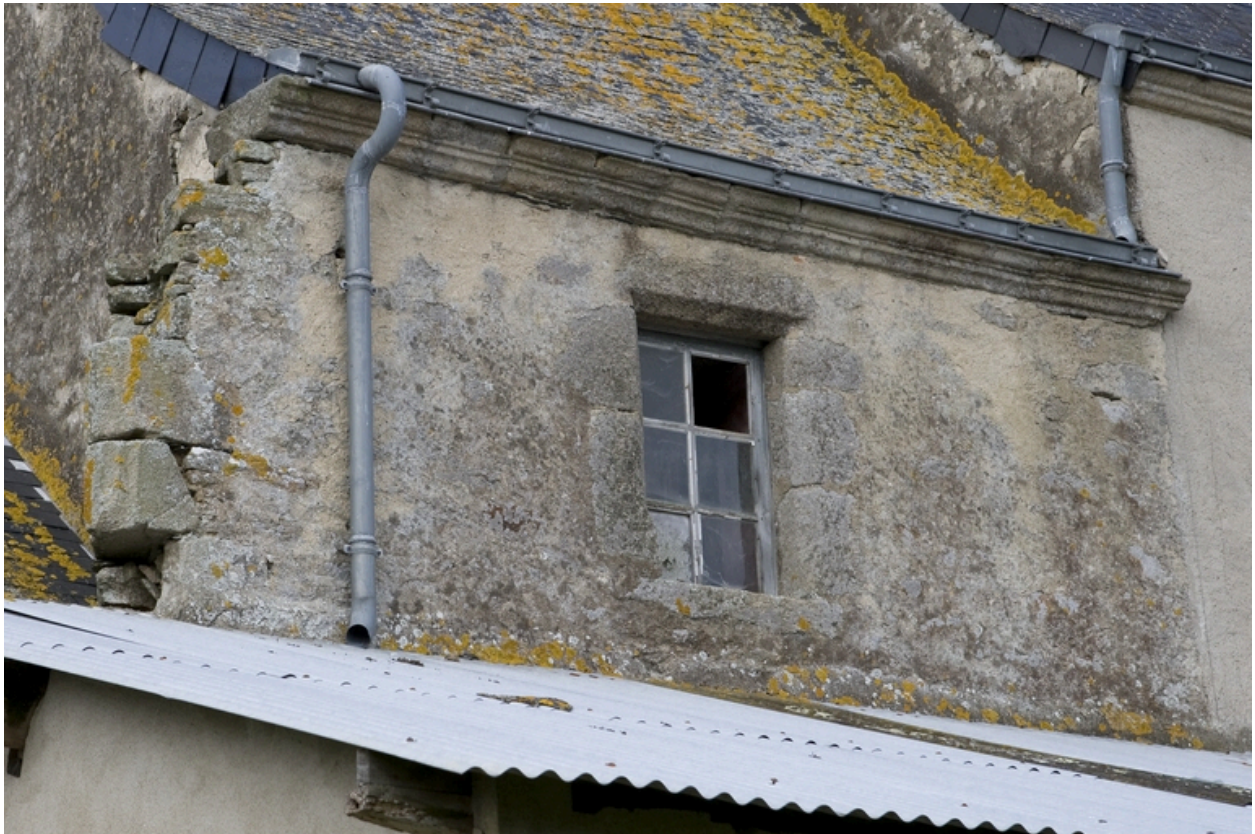
Logis. Partie est. Façade nord. Fenêtre de l'étage.
