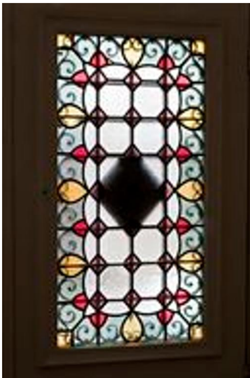
Porte d'entrée, verrière, panneau : vue d'ensemble.
