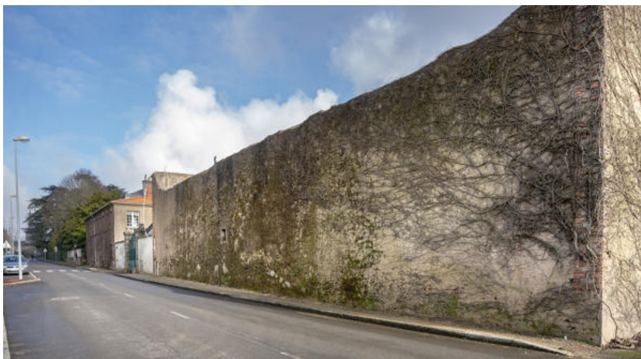
Bâtiment de stockage, après l'effondrement de la toiture, vue du sud.
