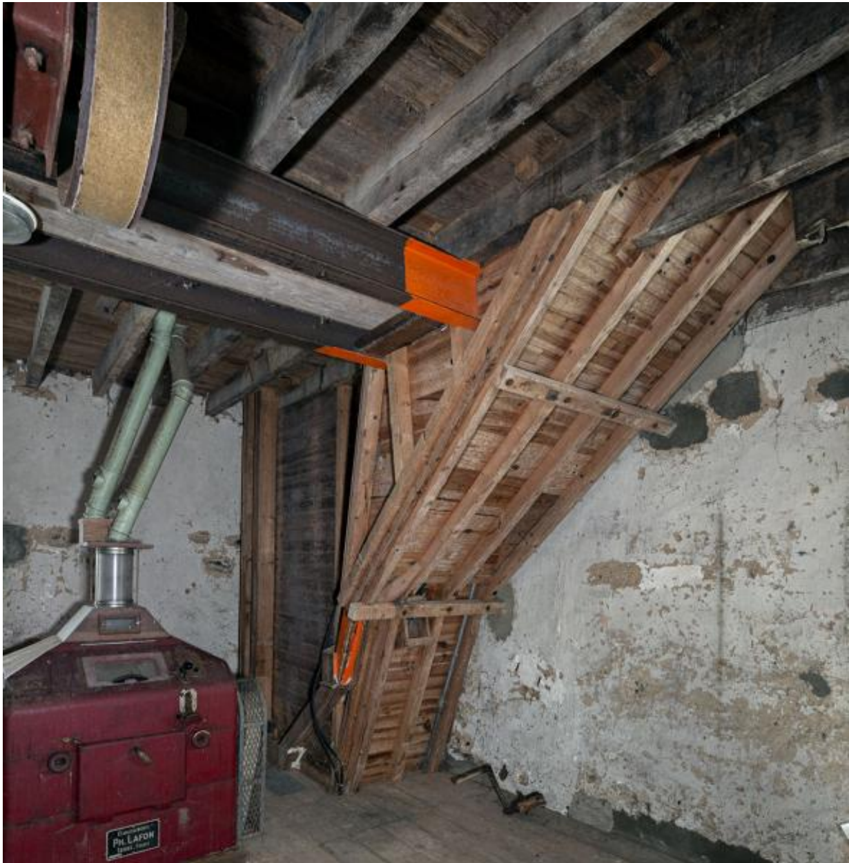
Premier étage, partie nord-est vue depuis le sud-ouest : la chambre à blé propre.
